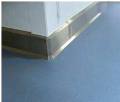
Beschichtung mit Terrazzooptik in Pharmabetrieb
