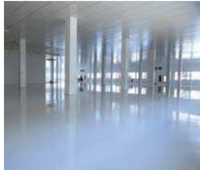
Fertige Beschichtungen auf Wand/ Stützen/Decke/Boden
