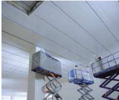
Aufbringen der Schlussbeschichtung an Decken
