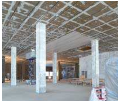
Schließen der Löcher und Lunker mit Egalisierspachtelung
