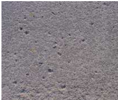
Löcher und Lunker in vorbereiteter Betonoberfläche
